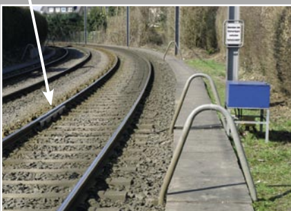
Kopfbenetzung an Bogeninnerschiene
